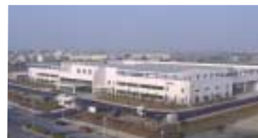
台湾新工場外観 すく横を新幹線が通る予定
