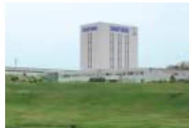
高さ45mの高層実験棟などを最新の設備を備えた滋賀事業所新工場
