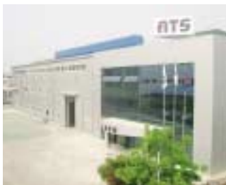
ATS第2工場。左側が有効高さ8m・940㎡の生産エリア
