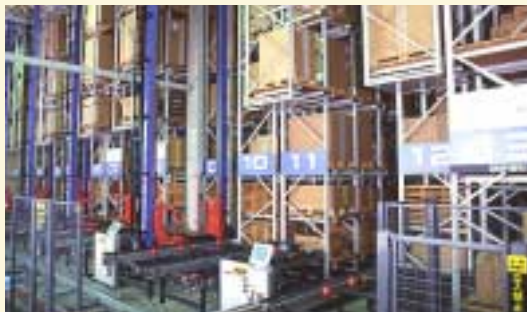
パレット自動倉庫「コンパクトシステム」/紙卸売業界
